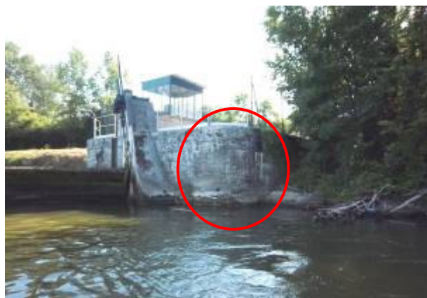
2.3 - Arrondi aval renforcé au béton
