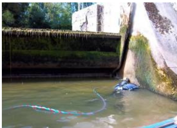
2.2 – Inspection joue d'étanchéité
