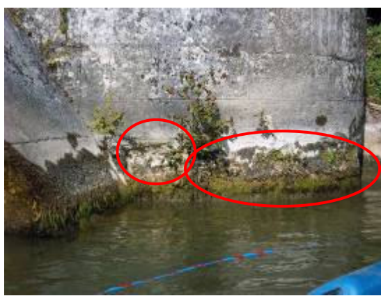
2.6 – Pierre érodée + érosion au niveau ligne d'eau
