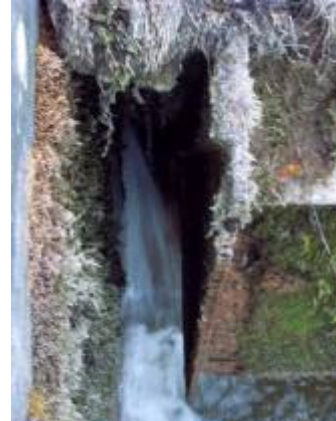
4.14 - Fuite clapet RD – Parement endommagé
