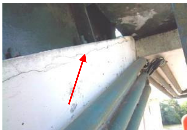
4.6 – Fissure sur massif de vérin côté pertuis
